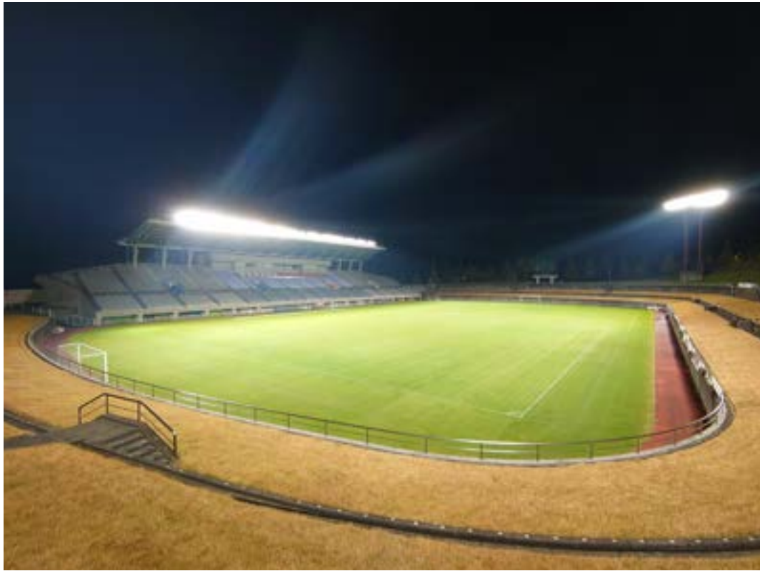
B 鉄塔側から
