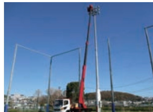
照明設置作業
