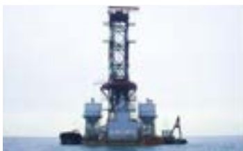
深層混合処理船 DCM3 号船
