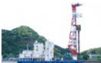
深層混合処理船 DCM8 号船
