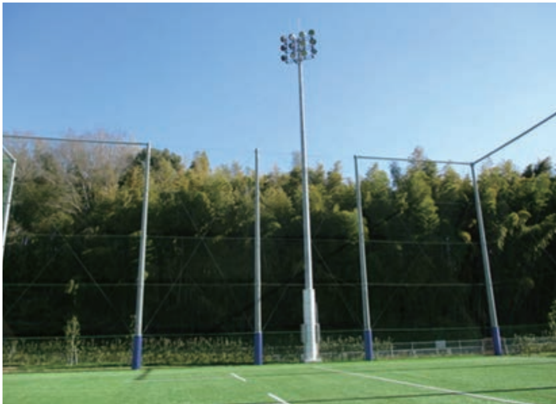
25m 照明ポール
