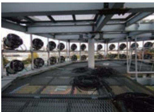
センターボール内部
