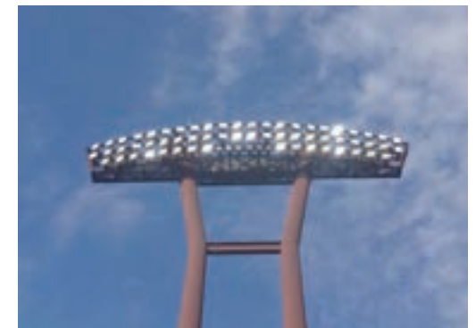
鉄塔 架台部分
