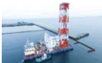
深層混合処理船 DCM6 号船
