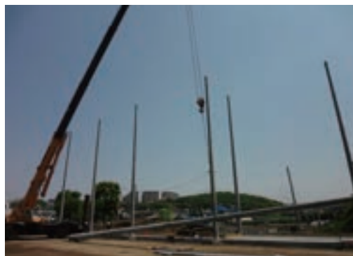
ポール柱つり込み
