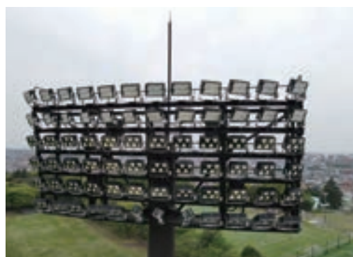
鉄塔 架台部分
