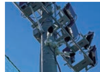
上部 LED 照明と下部 AI カメラ
