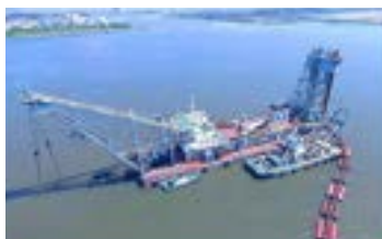
ポンプ式浚渫船 筑波丸
