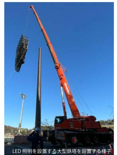
LED照明を設置する大型鉄塔を設置する様子
